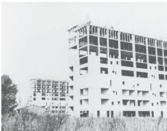
Chantier de La Peupleraie à Fresnes (1955-1962)
